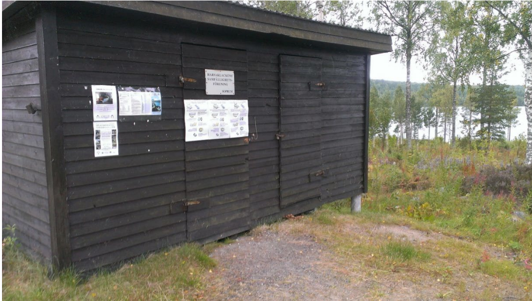
Befintlig återvinningsstation inom planområdet.
